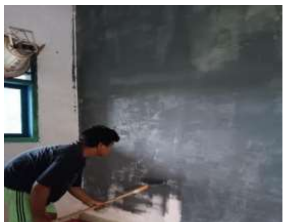
Gambar 5. Perbaikan Perpustakaan Baca
