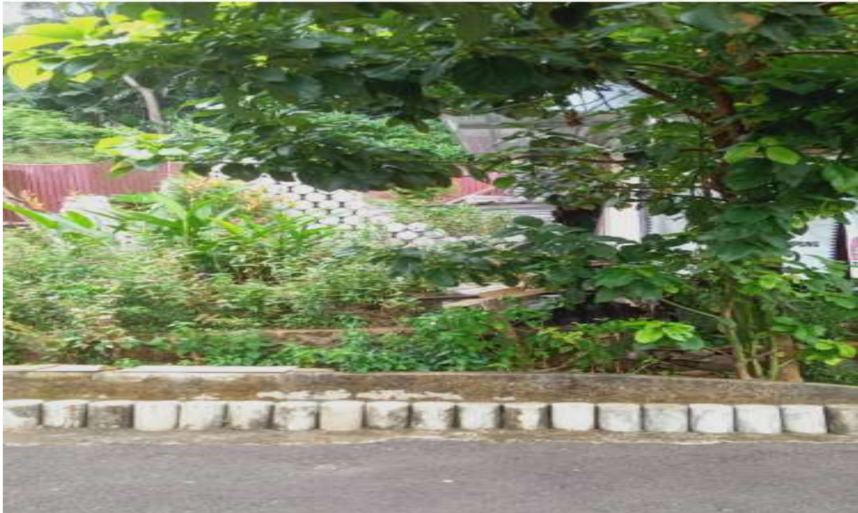
Gambar 10. Pemanfaatan limbah pengujian beton silinder untuk energi konservasi pada lingkungan yang asri dan menyejukkan serta untuk mempertahankan struktur tanah lereng dari erosi atau banjir
